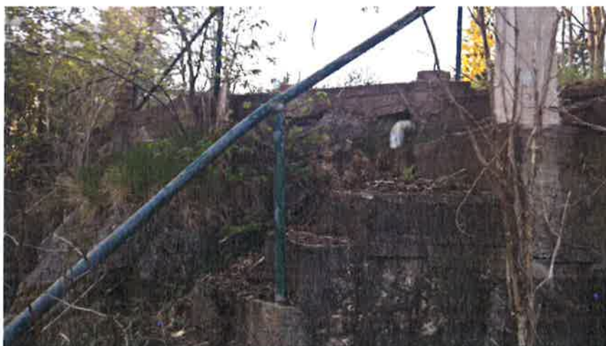
Foto 8 – Berg i dagen och befintlig stentrappa
