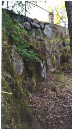
Foto 6 – Berg i dagen och befintlig terrassmur
