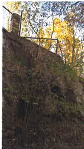
Foto 7 – Berg i dagen och befintlig terrassmur
